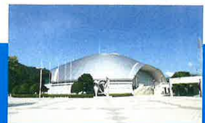
静岡県立水泳場
